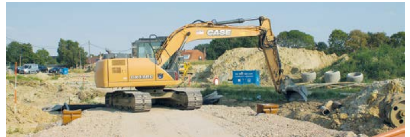
aanleg bedrijvenzone 'De Vlaamse Staak'
