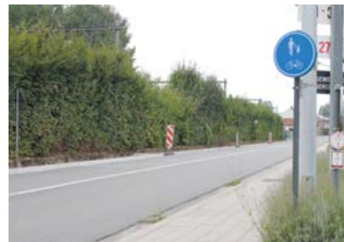
heraanleg voetpaden Eeksen
